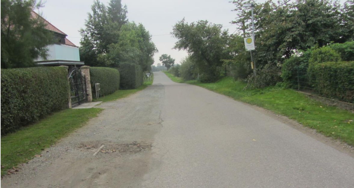
Abb. 1: Blick in die Ausbaustrecke Bereich Bauanfang Hundehagen
