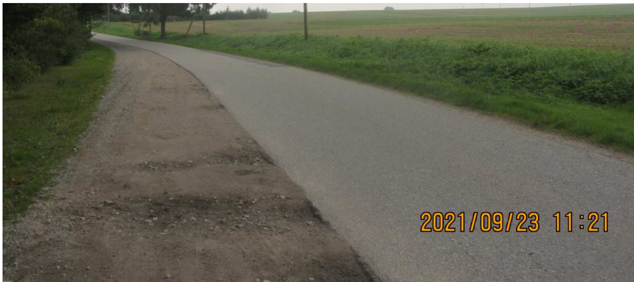
Bild 3 Blick auf den Stationsbereich um 0+400 in Richtung Bauanfang
