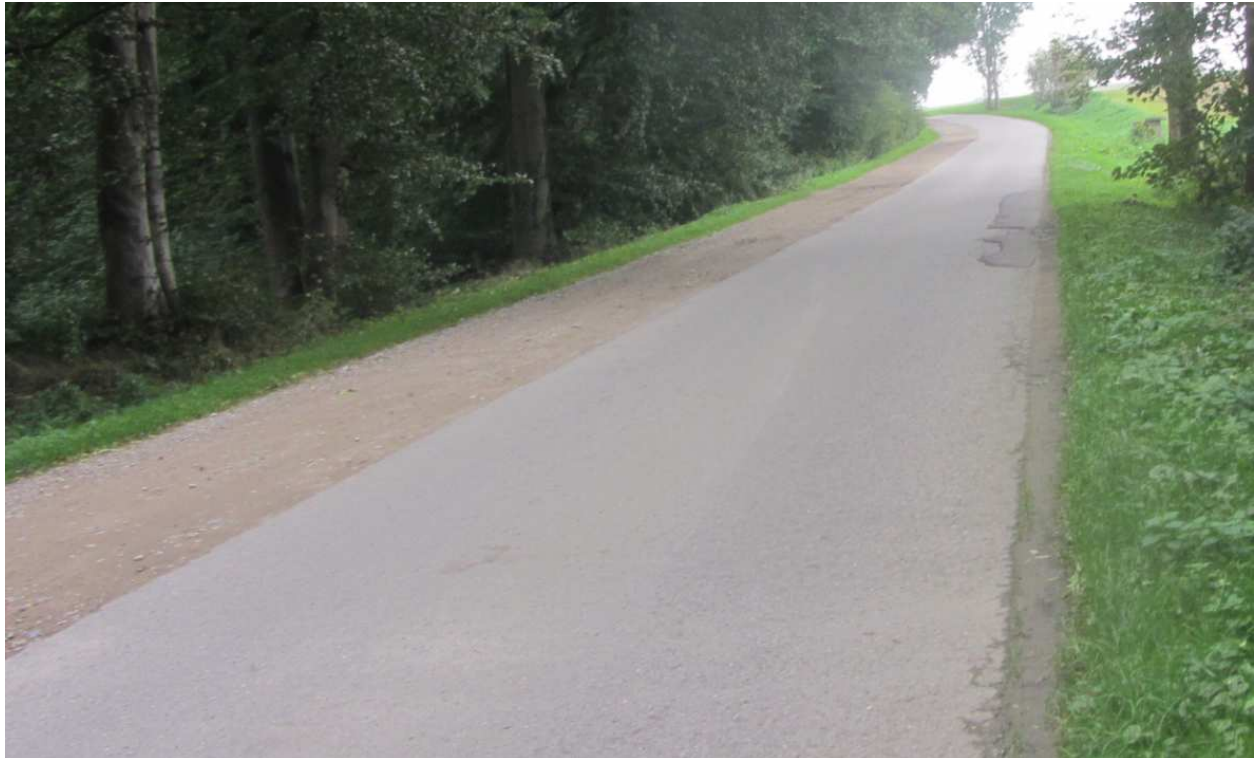
Bild 4 Blick auf den Stationsbereich um 0+520 in Richtung Bauanfang
