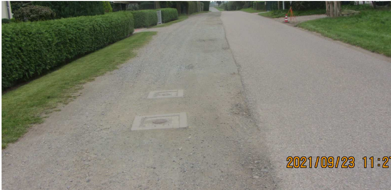
Bild 2 Blick auf den Stationsbereich um 0+140 in Richtung Bauanfang
