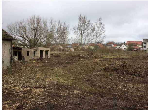
Nördlicher und westlicher Plangebietsrand mit Resten baulicher Anlagen.
