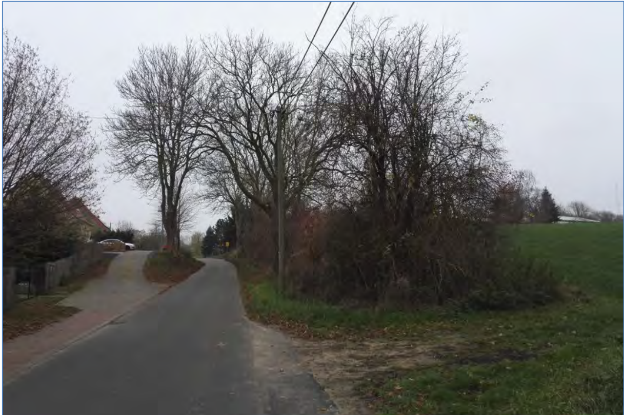
Abb. 3 Auffahrt und Böschungsbewuchs
