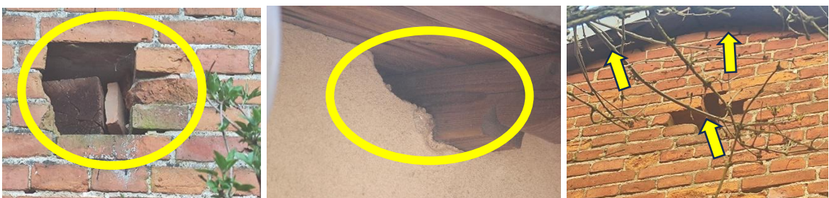
Bsp. 11.04.2025 Feuerwehr Quartierbereiche Mauerwerk / Dachbereich
