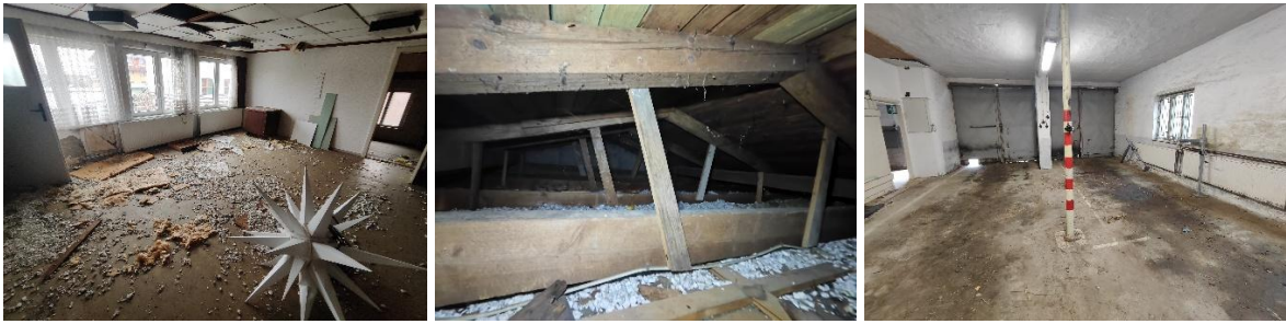
Bsp. 03.12.2024 Gerätehaus Feuerwehr Innenräume
