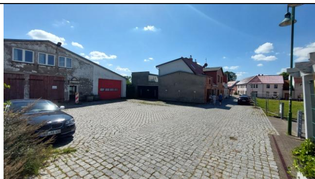
Ehemaliges Feuerwehrgebäude an der Schwaanschen Straße. Der nördliche Teil wird zurückgebaut.
