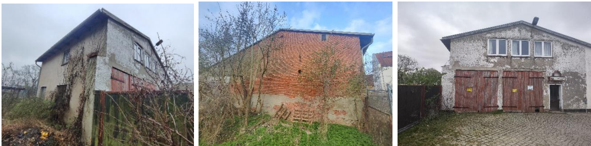
Bsp. ehemaliges Feuerwehrhaus Hof- und Straßenansicht
