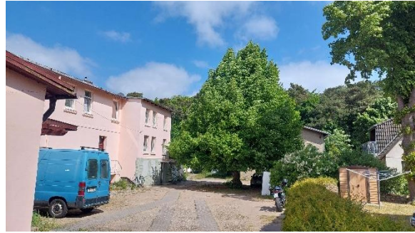
Hofansicht mit langgestrecktem Anbau und Linde
