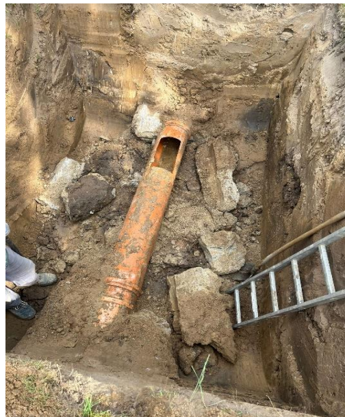
Schacht 2 (Leitung war in Magerbeton gelegt)
