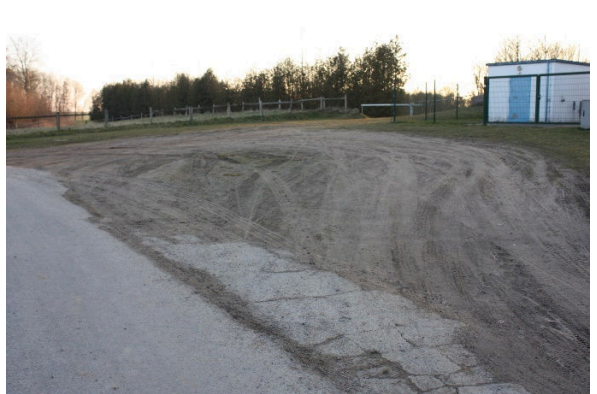
Vorhandene Verkehrsflächen an der Straße Am Sportplatz
